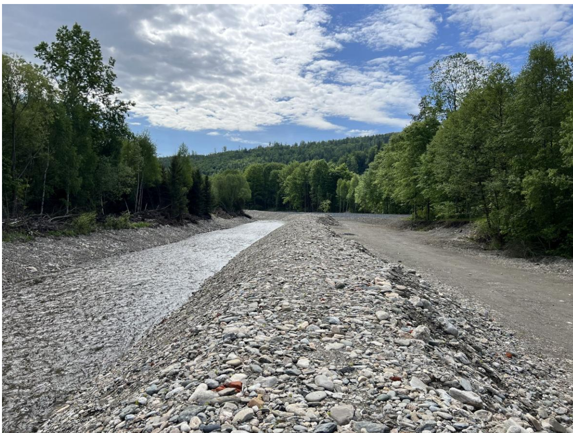
Obr. Opava ř.km 107,8 po zabezpečovacích pracích
