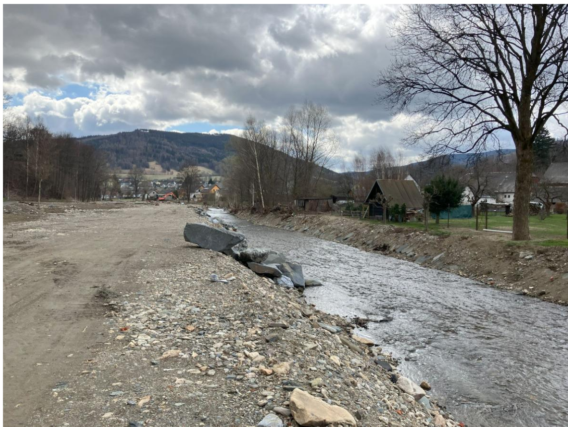
Obr. Černá Opava ř.km 0,8 po zabezpečovacích pracích
