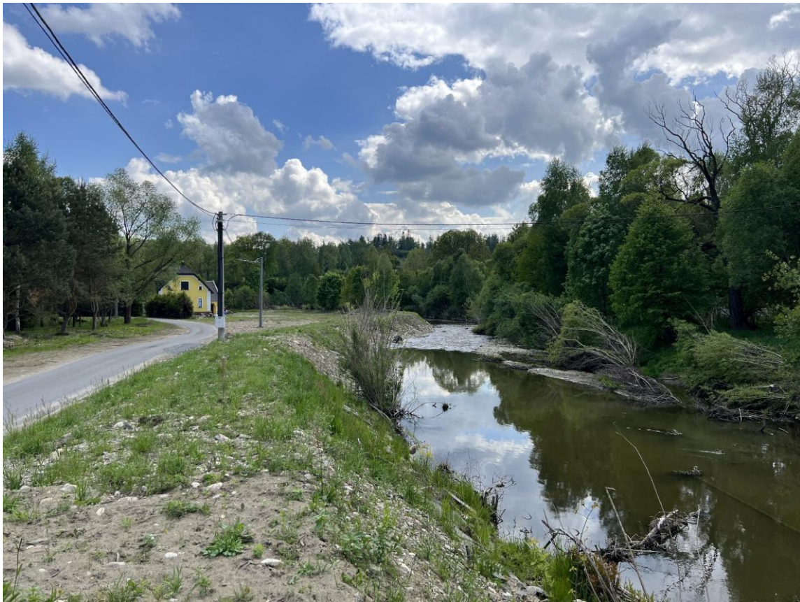
Obr. Opava ř.km 96,8
