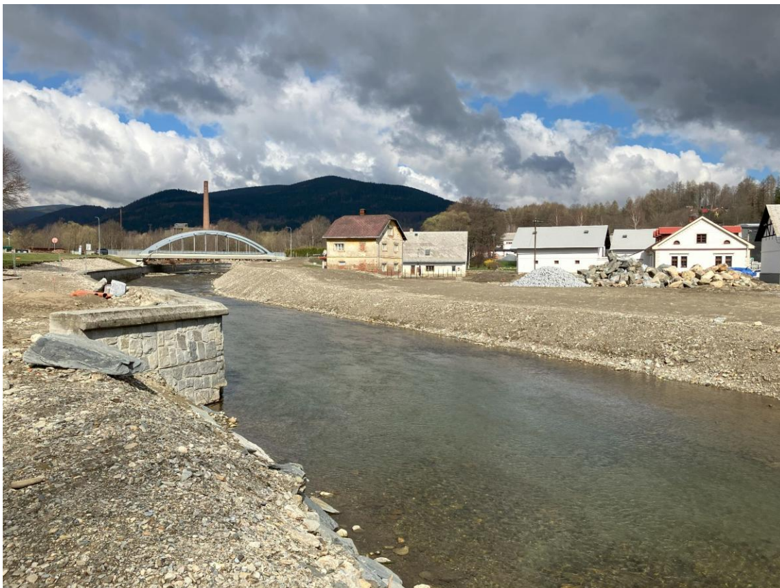
Obr. Opava ř.km 109,8 po zabezpečovacích pracích
