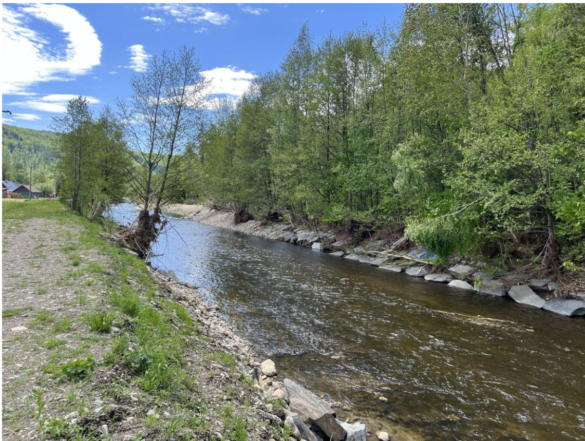
Obr. Opava ř.km 104,0
