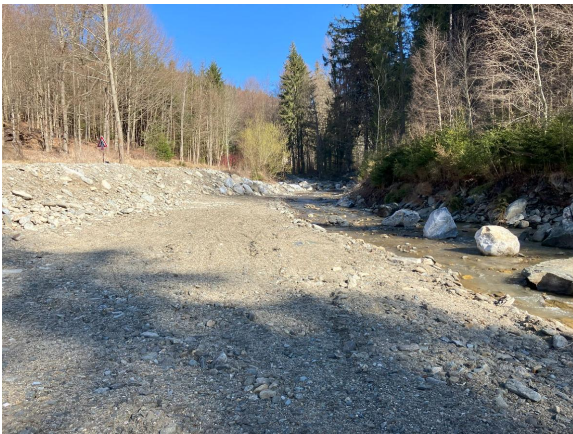
Obr. Bílý potok ř.km 0,5 po prohrábce
