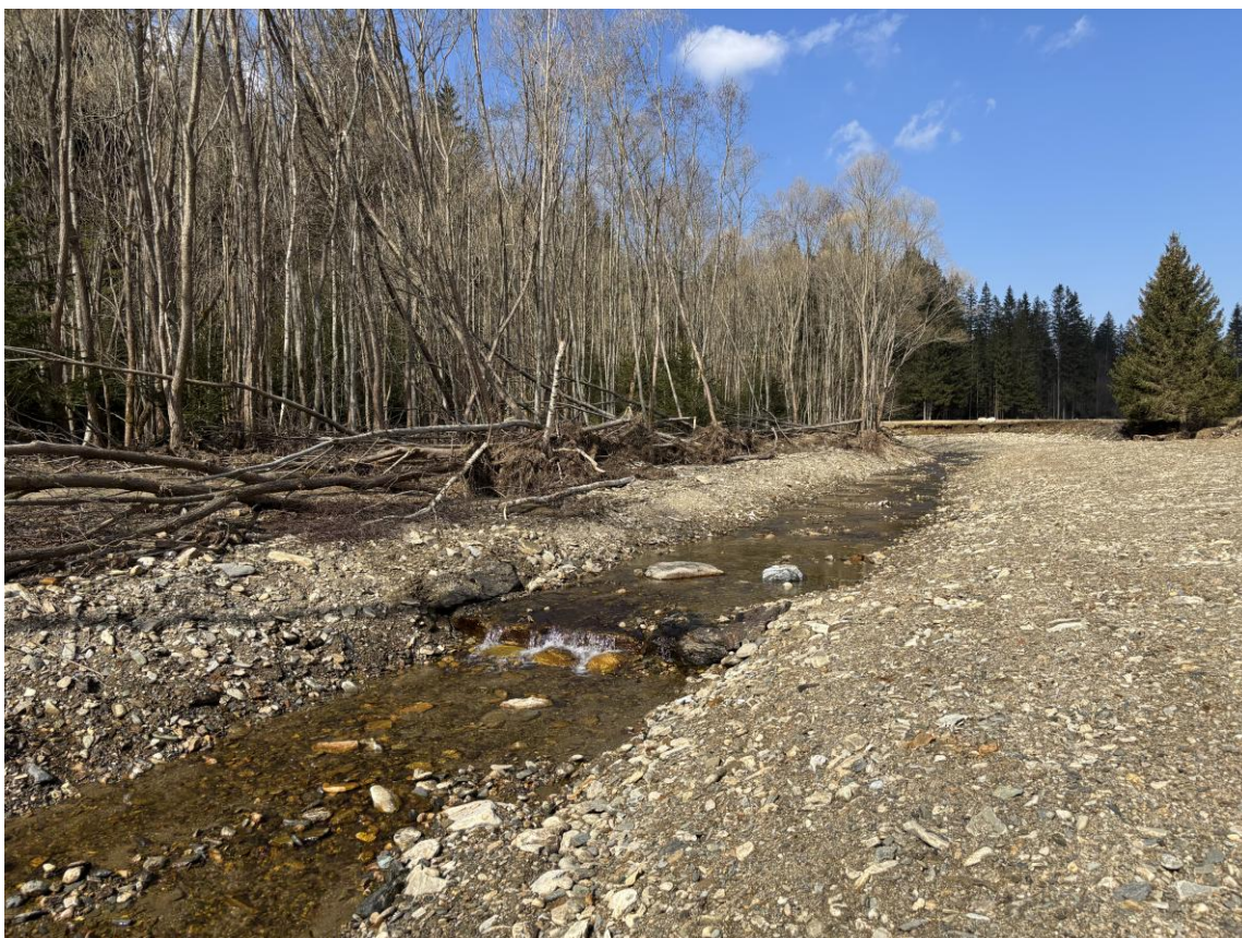
Obr. Černá Opava ř.km 5,0 po zabezpečovacích pracích
